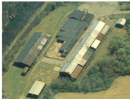
A & A Metal Fabrication Site
